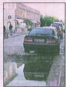
Ur gropen i gatan forsoade vatten ut från den trasiga vattenledningen.
